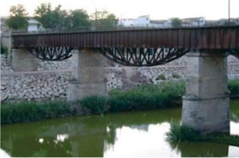
Puente Viejo sobre el río Guadalimar
