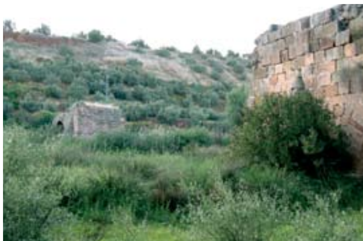
Puente Mocho. Sobre el río Guadalimar.
